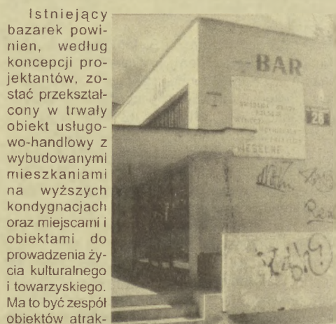
Opuszczony i zdewastowany od kilku lat bar Hutnik przy ul. Przy Agorze fot. M.K.
