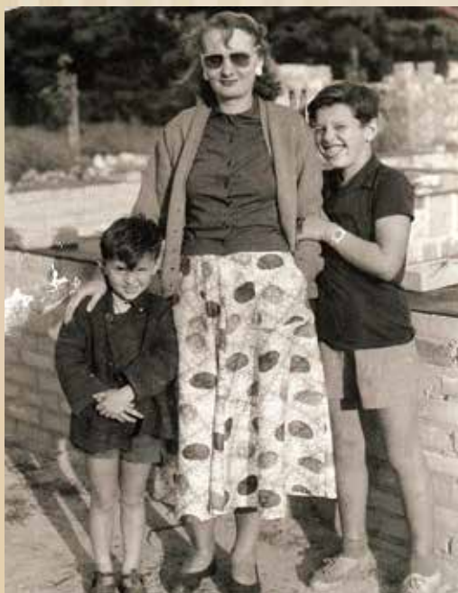
Ja z Andrzejem i Krzysiem przy budowie domu siostry męża, Zofii Kaczorowskiej na ul. Górnej
