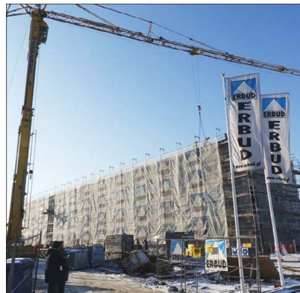
Budowa przychodni na Chrzanowie
