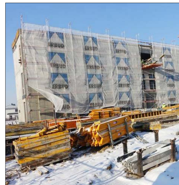
Prace na budowie przychodni trwają mimo zimy
