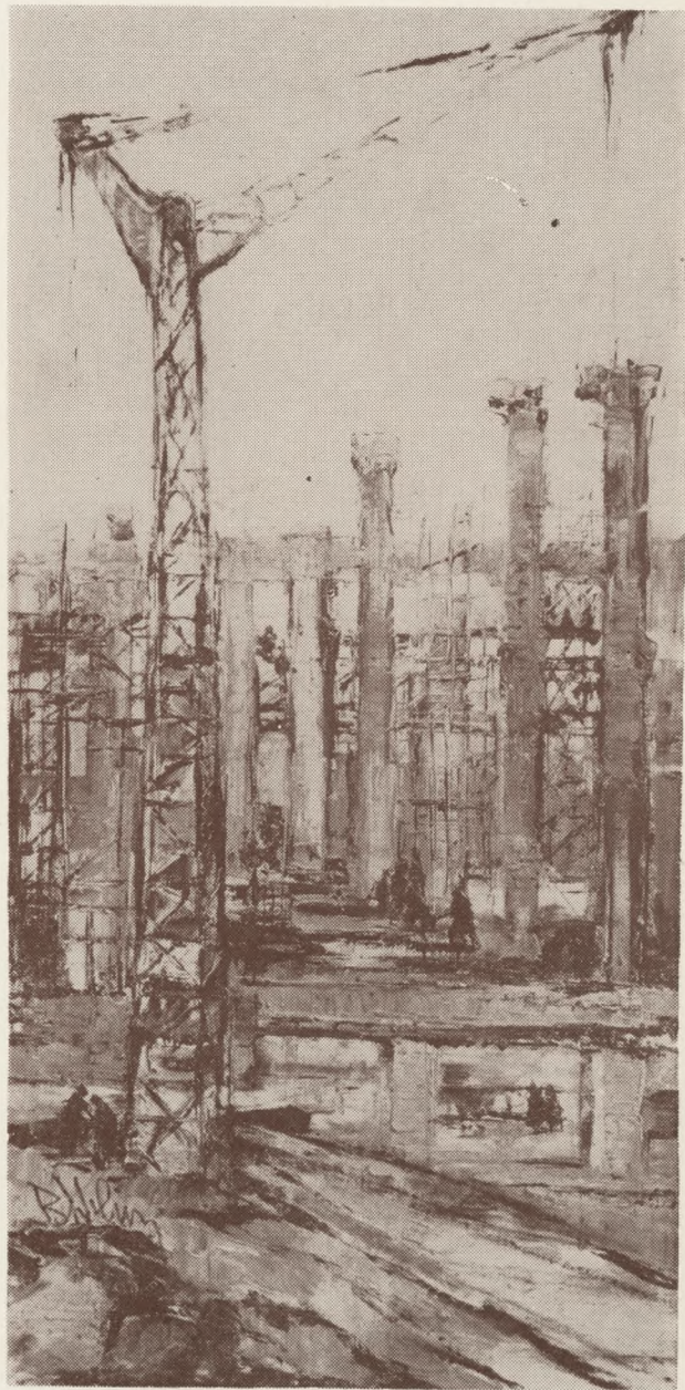
Budowa Dworca Centralnego, 1975
