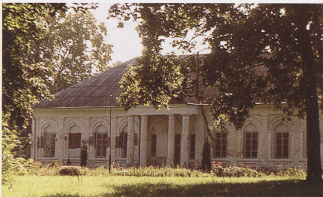
Żeźmory dwór Tyszkiewiczów poł. XIX w. Architekt Wawrzyniec Cezary Anichini (na fundamentach dworu 2. poł. XVIII w.
