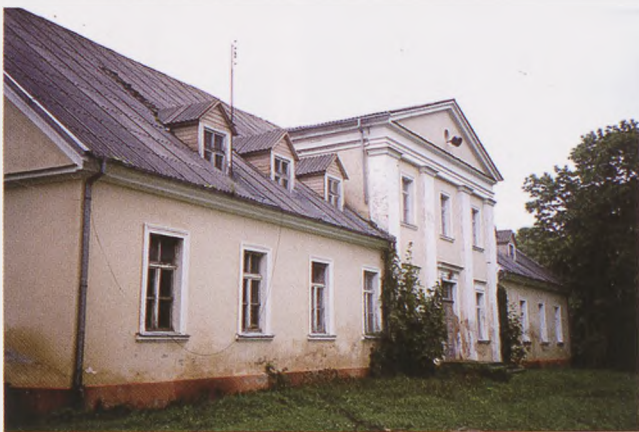
Ilzenberg. Dwór Dymśzów 2. poł. XIX w. po 1945 r. pensjonat dla notabli, obecnie nieużytkowany, choć pilnowany przez stróża
