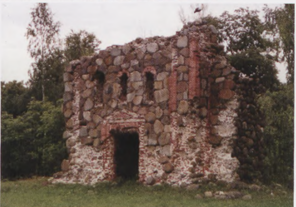
Solomieść (Salamiestis) – ruiny dawnej bramy wjazdowej do dworu
