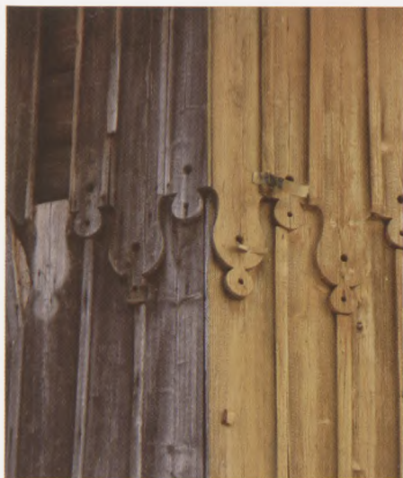
Pierwotny szalunek ścian dawnego kościołka
