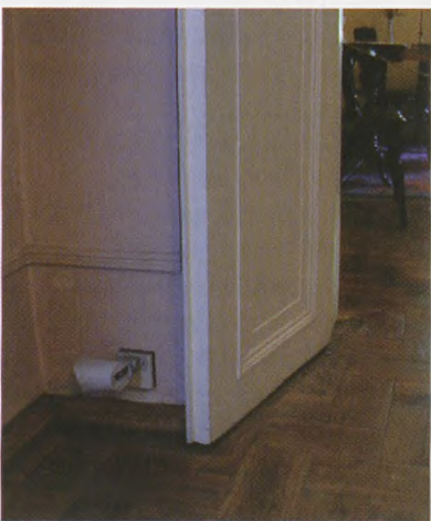
Samo posiadanie systemu alarmowego nie oznacza, że muzeum ma właściwe zabezpieczenia elektroniczne (zawsze można je źle zainstalować)
