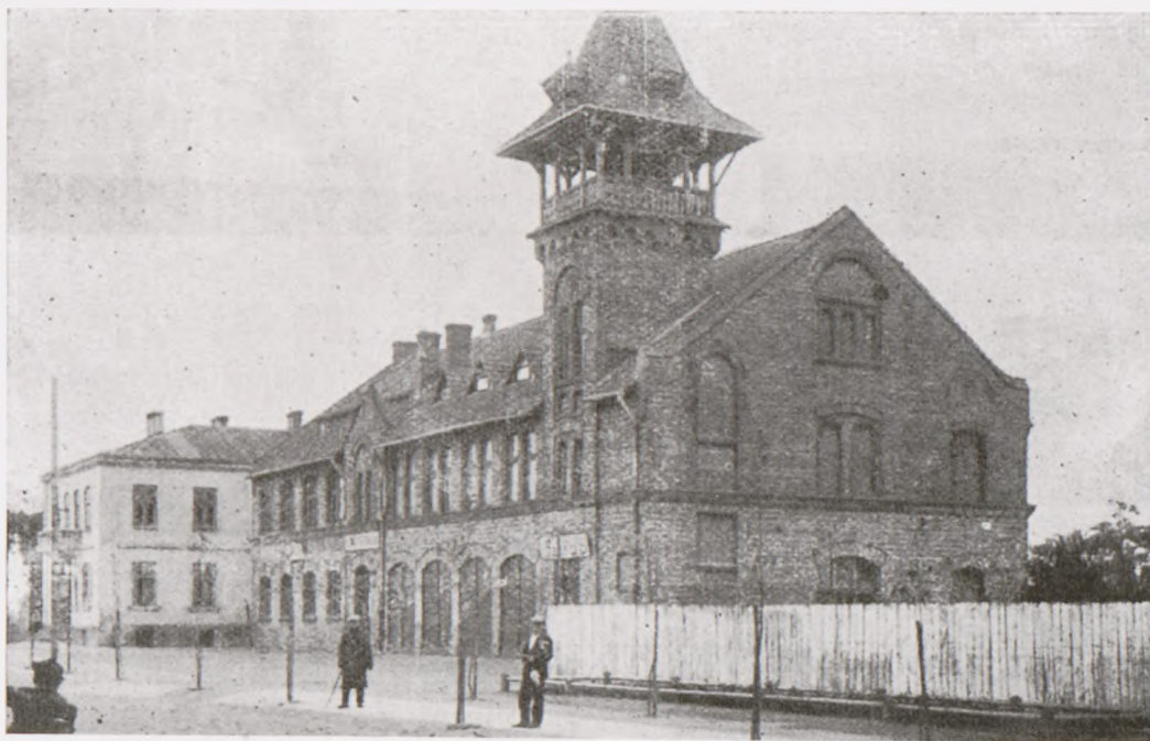
Budynek Straży Ogniowej.
