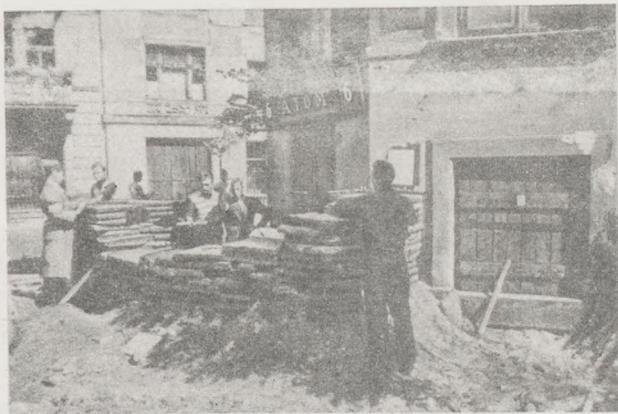
1. Budowa stanowiska ogniowego przy ul. Zgoda.
