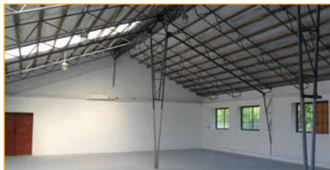
Wnętrze hali po remoncie.
