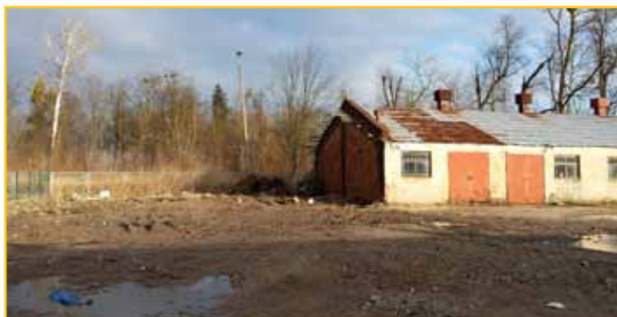
Hala nr 1 przed remontem.
