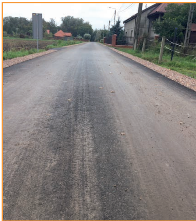
Łązy - gotowa droga
