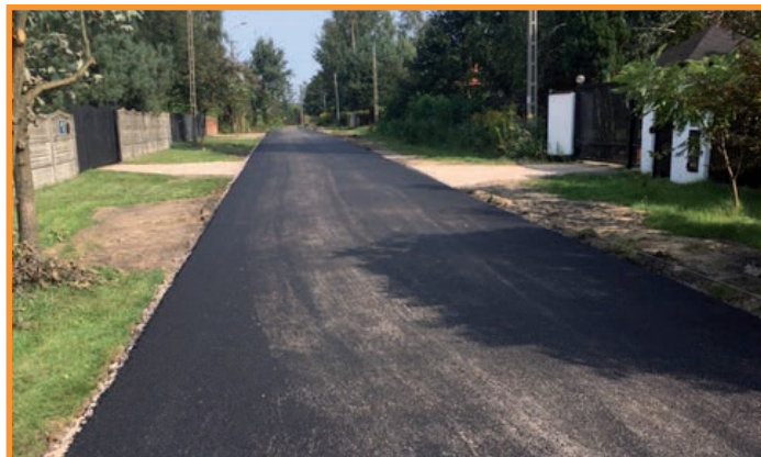
Sasanki – położona pierwsza warstwa wiążąca
