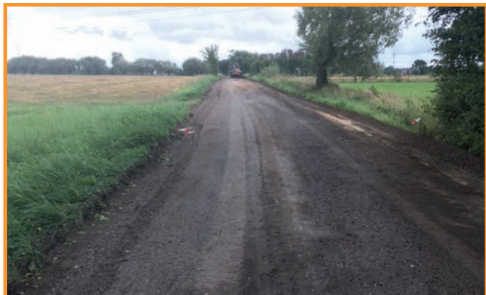
Kirsztajnow – początek prac
