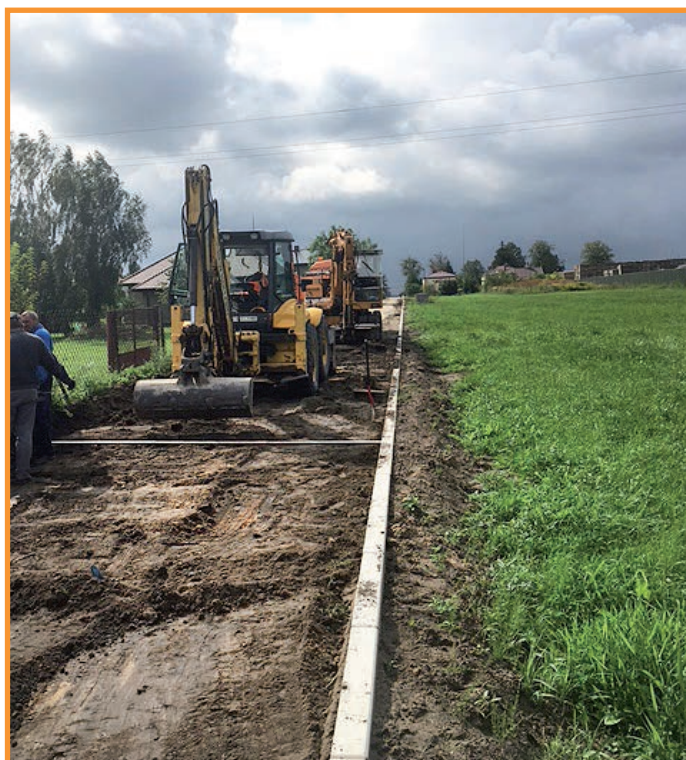
Przygotowywanie podłoża - ul. Ks. Skibniewskiego
