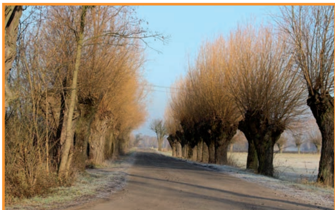
Kirsztajnow – droga przed przebudową stan na 2016 rok
