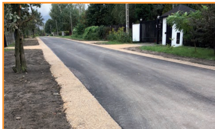
Sasanki – nowa droga z zabezpieczonym poboczem
