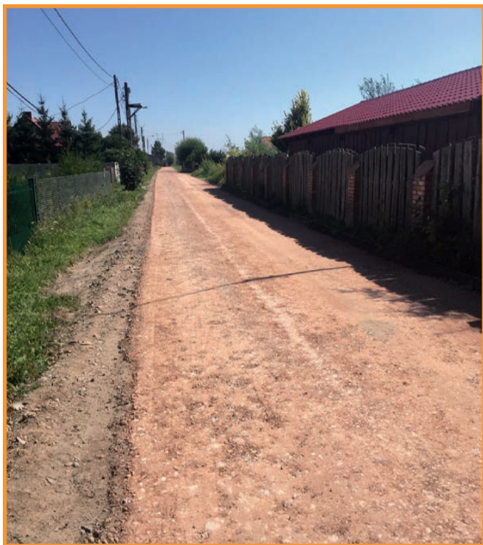
Łązy - początek prac
