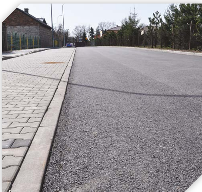
Chodnik i nowa nawierzchnia
