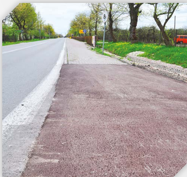
Połączenie ścieżki z istniejącym odcinkiem
