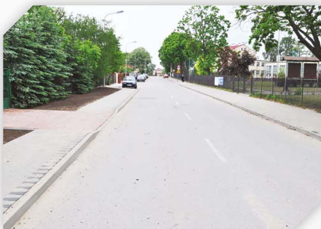
Brak słupów linii napowietrznej
