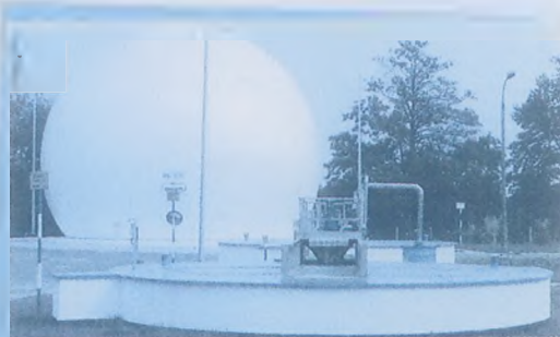
Modernizacja oczyszczalni ścieków – zbiornik na biogaz
