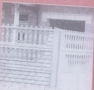
Betonowe płoty przy nowo budowanych domach
