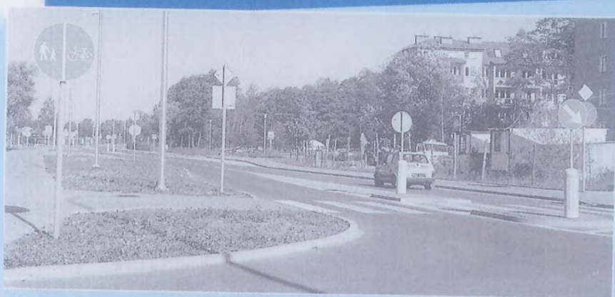
Nowa droga na osiedlu Bairda – ul. Teligi
