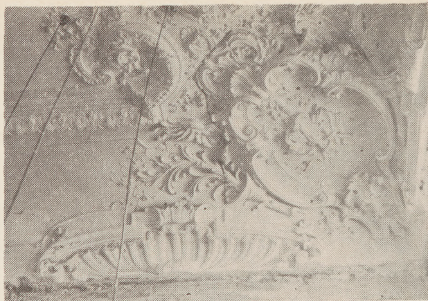
9. Fragment dekoracji sztukatorskiej plafonu biblioteki wg proj. Z. Hendla, stan z 1977 r.
