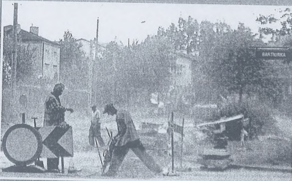
Modernizacja nawierzchni ul. 3 Maja
