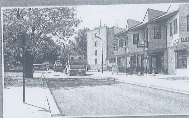
Asfaltowanie ul. Kopernika
