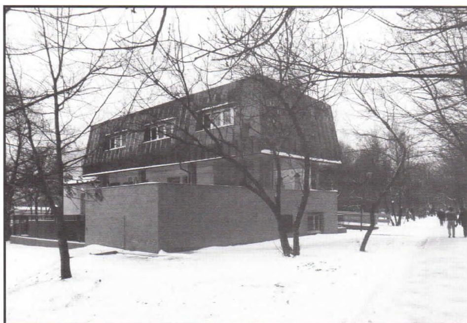
Nowy gmach poczty i centrali telefonicznej. Widok od strony ul. Dworcowej.
