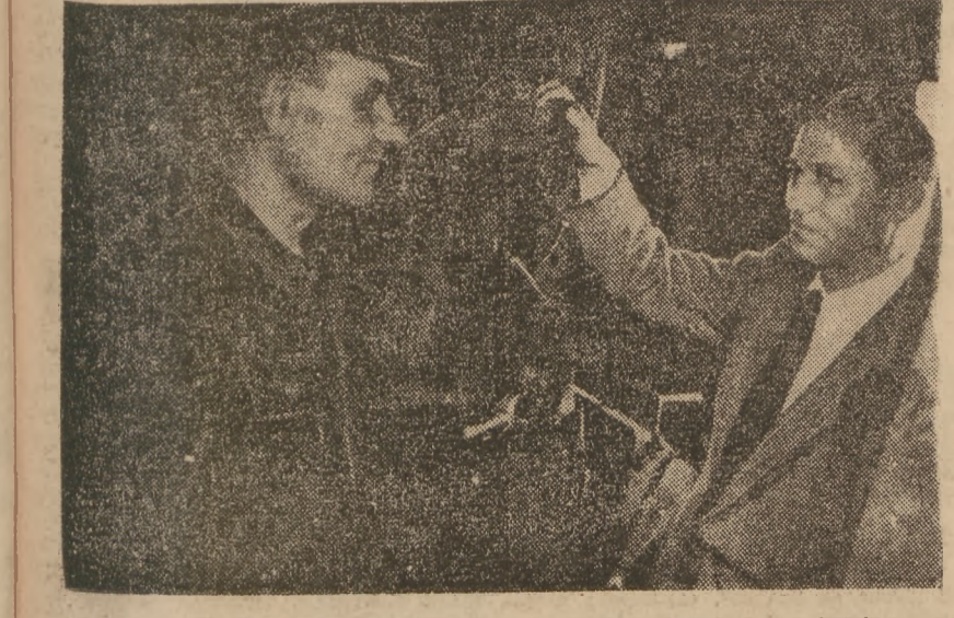
Wczoraj zakończono wszystkie próby wytrzymałości mostu kolejowego pod Cytadela. Na zdjęciu min. Rabanowski wraz z maszynistą Wólcem- ktem uruchamia pierwszy próbnny pociąg.
