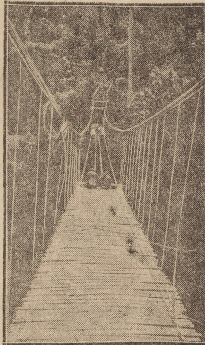
Rys. 1. Most wieszarowy z prętów trzciny, przeznaczony dla transportu na mulach.
