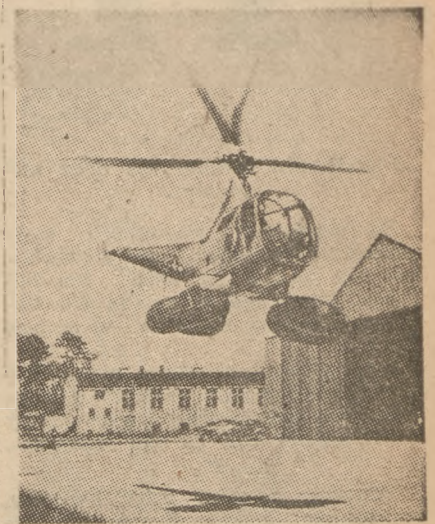
„Uzbrojony” w pływaki helikopter staje się zdolny do wodowania.
