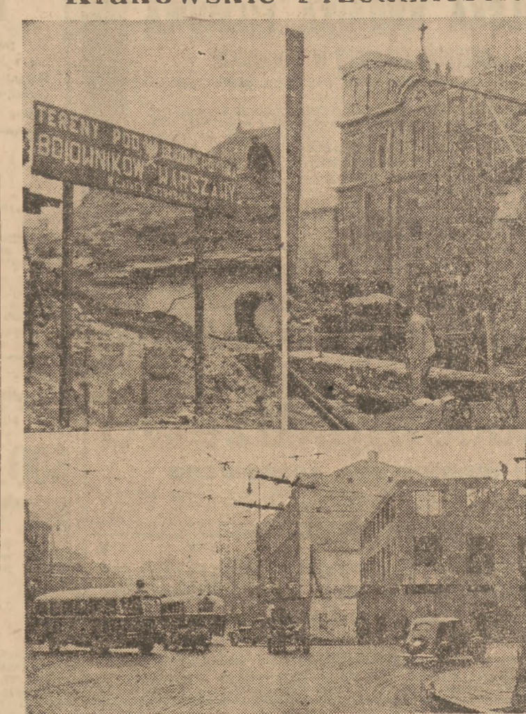
Oto fragmenty z odbudowy Krakowskiego Przedmieścia: u góry - z prawej zakładanie fundamentów pod „Dom Studenta” przy Uniwersytecie Warszawskim; u dołu - budowa nowego domu u wylotu ul. Królewskiej.
