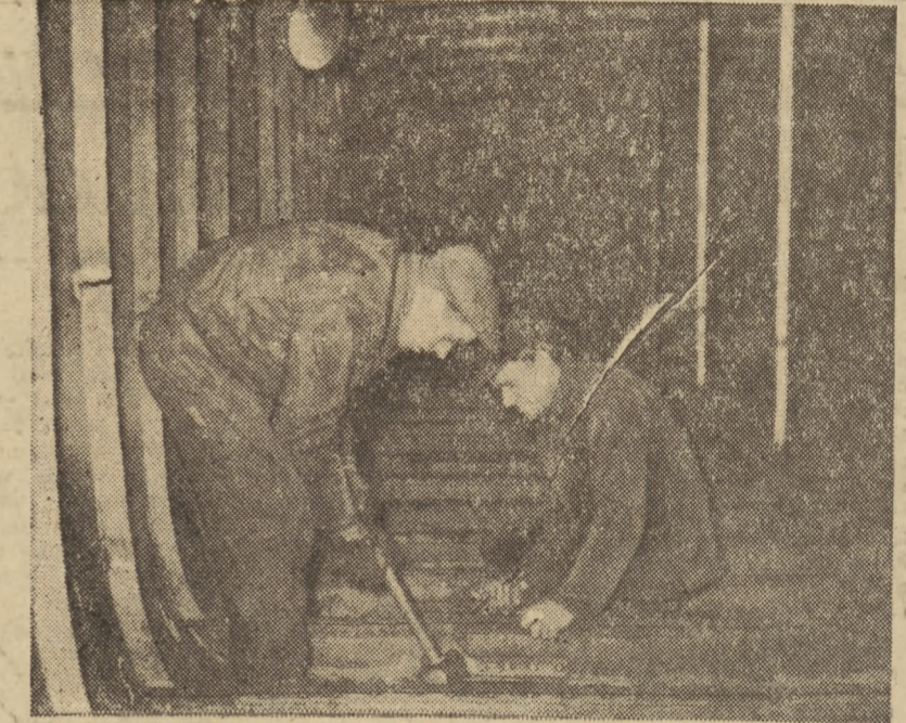
Błachy na dnie „Traugotta” wymagają wymiany. Stare i zużyte mogłyby przecież przepuścić wodę.
