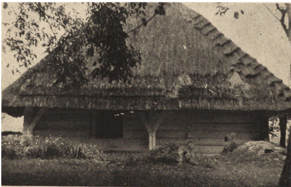
Ryc. 260. Grzęska, pow. przeworski — chałupa. Rygiel i krzyżowe pietnary zostały usunięte po późniejszym wycięciu w ścianie okna.
