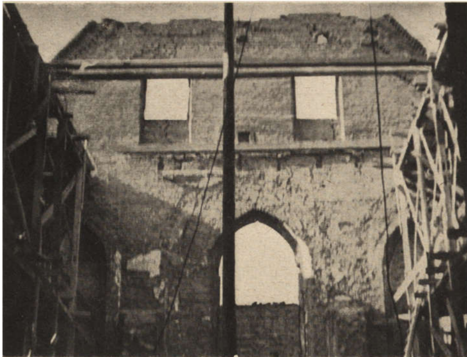
Ryc. 246. Ściana szczytowa zachodnia widziana od wnętrza. Stan po zniszczeniu.
