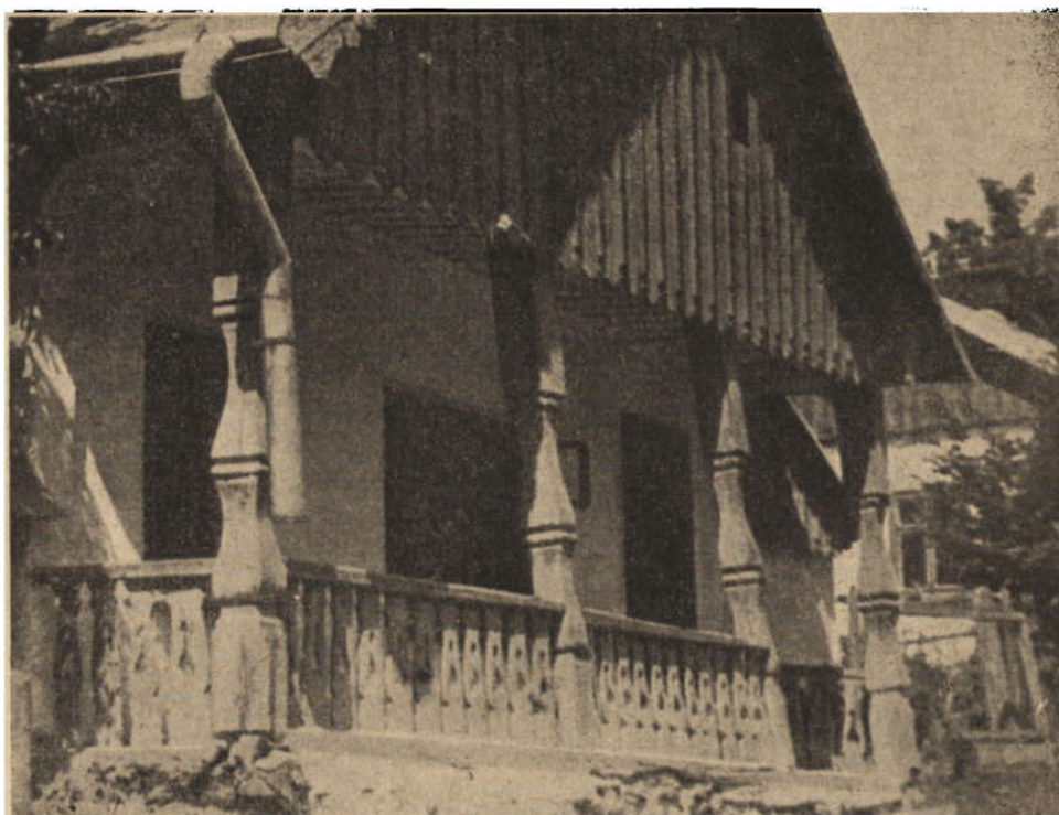
Ryc. 257. Dom podcieniowy przy ul. Kańczudzkiej (fot. z 1952 r.).
