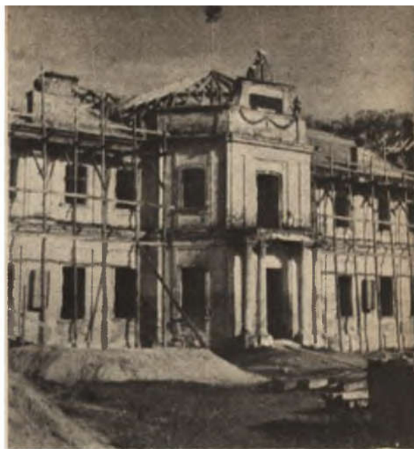
Ryc. 299. Narol, pow. lubaczowski — elewacja frontowa pałacu po odbudowie więźby dachowej. Stan z r. 1952.
