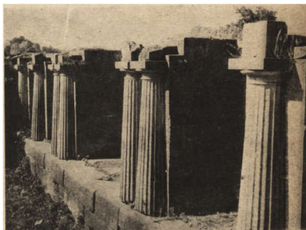
Ryc. 309. Nietulisko Fabr., pow. opatowski — przepust wodny na Świślinie. (ok. poł. XIX w.)
