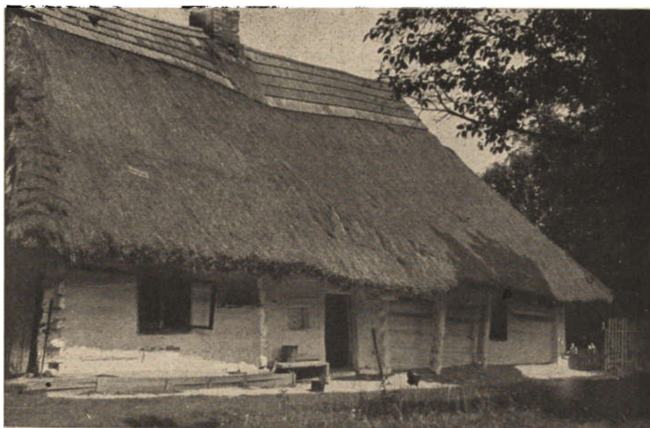
Ryc. 267. Grzęska, pow. Przeworsk — chałupa z pocz. XIX w. Dwa widoczne słupy dodane później, podtrzymują złamaną płatwę. Fot. z r. 1952.
