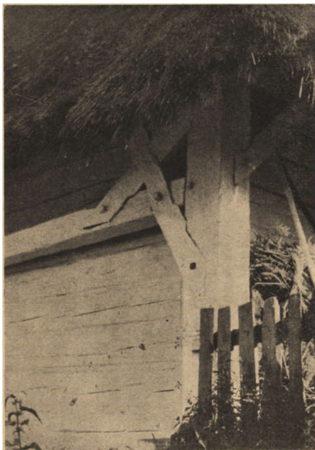
Ryc. 269. Białoboki, pow. Przeworsk — słup podtrzymujący wiązanie dachowe. Fot. z r. 1952.
