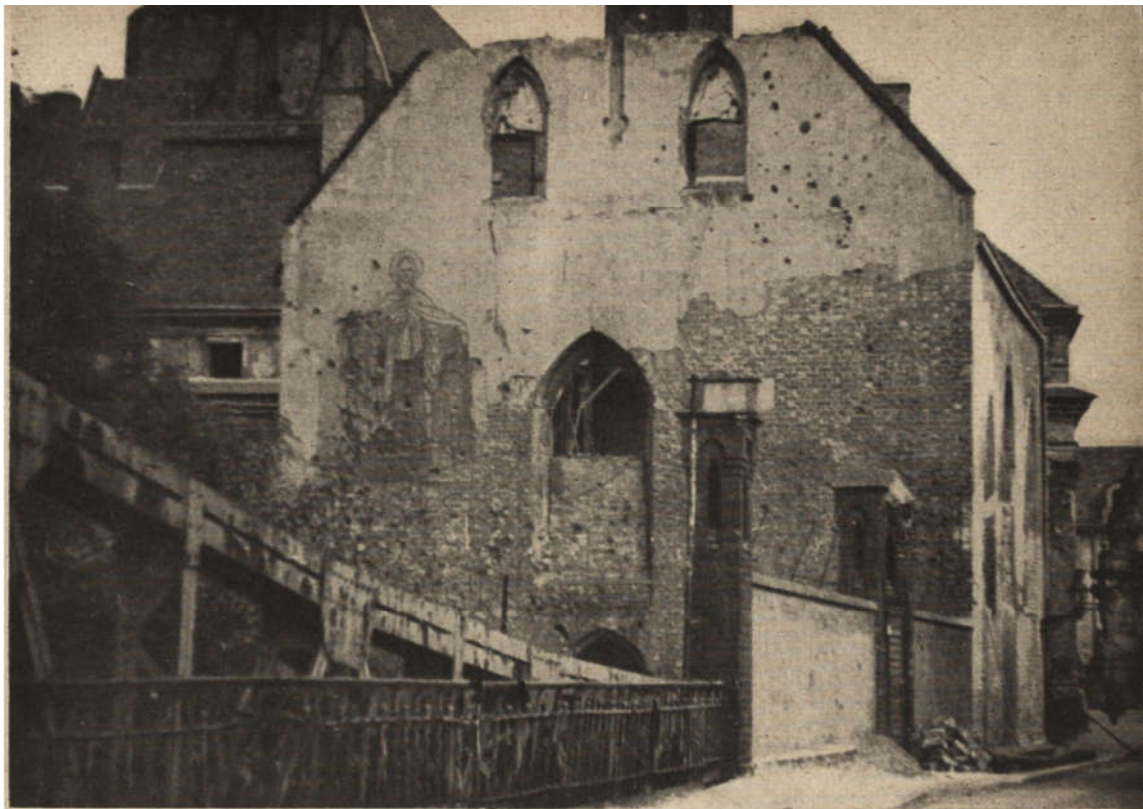
Ryc. 242. Wrocław, kościół św. Piotra i Pawła — elewacja zachodnia. Stan po zniszczeniu.
