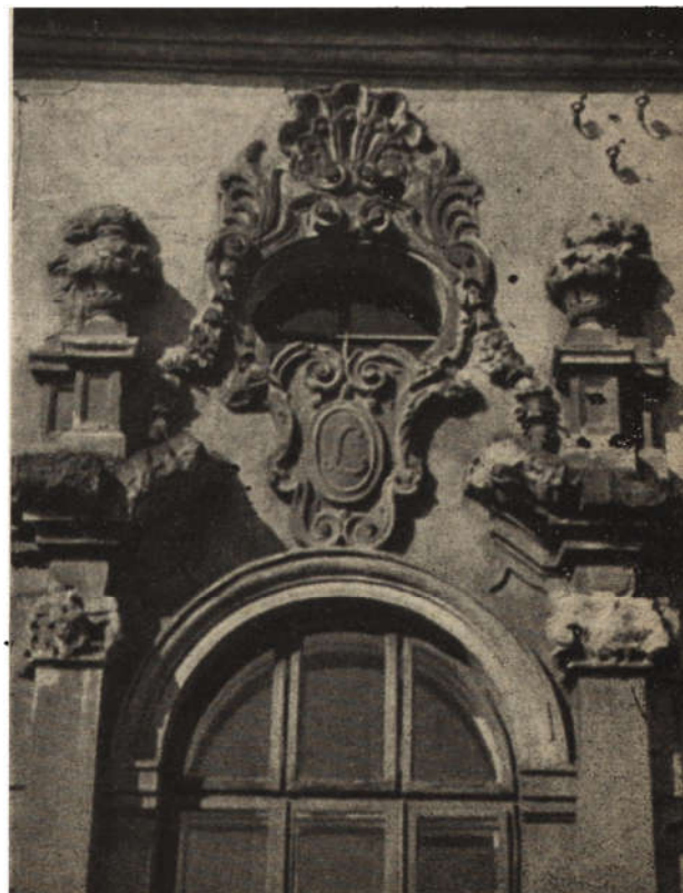
Ryc. 305. Rzeszów — pałacyk Lubomirskich z XVIII w. Fragment elewacji wschodniej. Zdjęcie z 1952 r.
