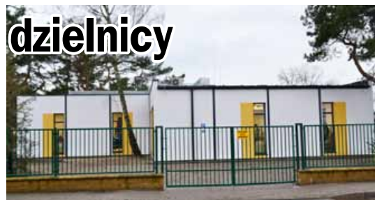
Dobudowana część do Przedszkola „Sosnowa Stacyjka” w Falenicy
