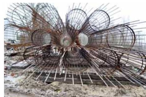
Zbrojenia przygotowane do dalszego montażu
