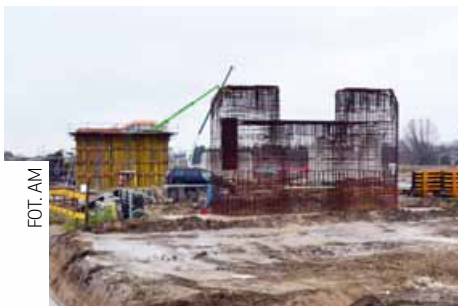
Miejsce budowy podpór pod wiadukt prowadzący z mostu w kierunku wschodnim
