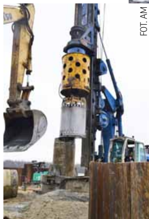
Wiercenie otworów w gruncie pod zbrojenie fundamentów podpór
