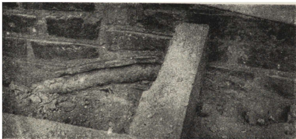
Ryc. 210. Odkryty w czasie badań muru fragment dawnego portalu — widoczny walek z cegieł profilowanych.
