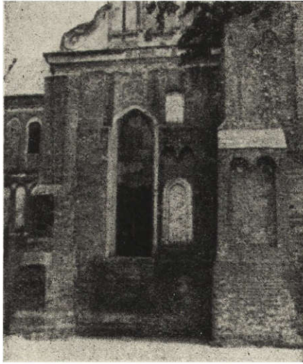
Ryc. 203. Fragment fasady zachodniej przed robotami konserwatorskimi.
