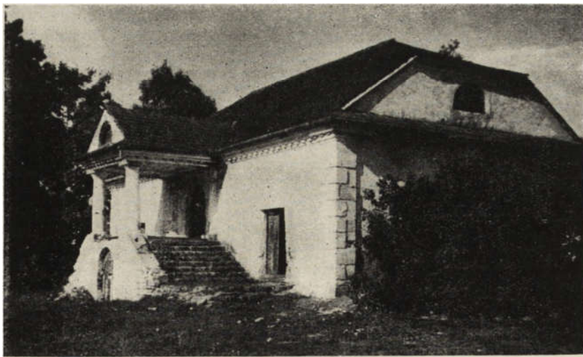
Ryc. 192. Lamus przy dworze w Rudzienku (1950).
