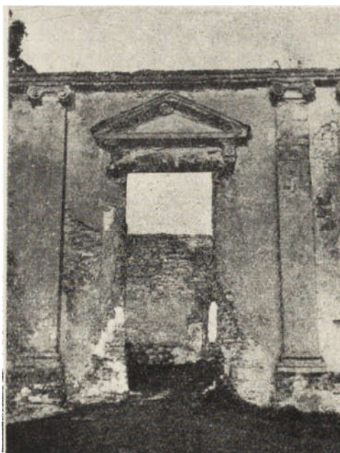
Ryc. 229. Fragment elewacji południowej pałacu.
