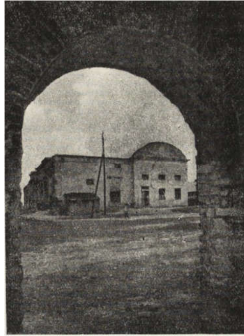
Ryc. 226. Widok z łamy zamkowej na pałac.
