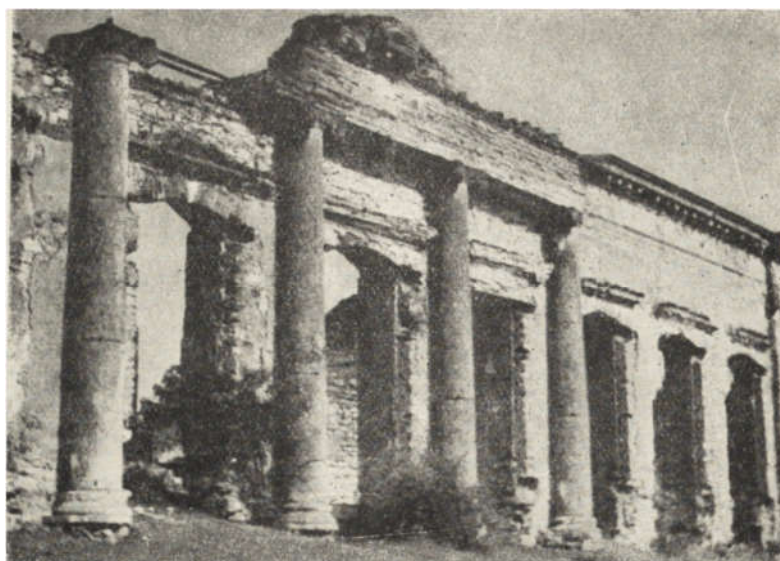
Ryc. 227. Fragment elewacji południowej pałacu.
