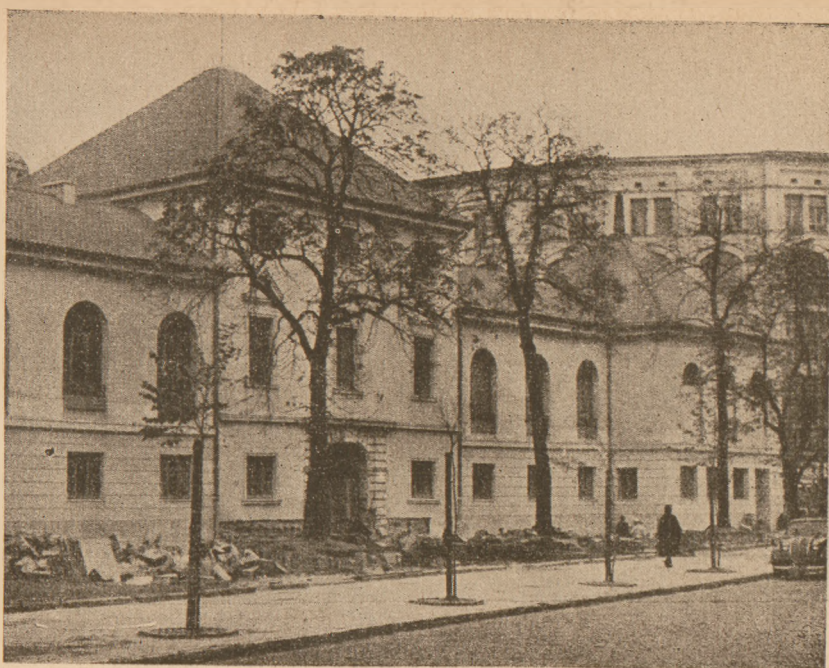
Arsenal w czasie przebudowy w r. 1938
