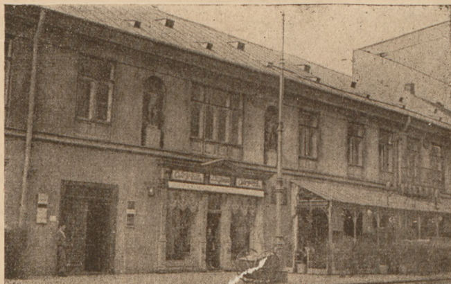
Front domu przy ulicy Miodowej 6
