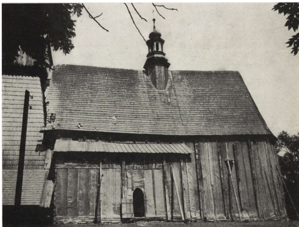
3. Haczów. Dawny kościół par. Widok od pd. — prowizoryczne zabezpieczenie ścian po rozebraniu sobót i zdjęciu oszalowania. Stan z 1962 r. (fot. Jerzy Langda, zbiory IS PAN)
