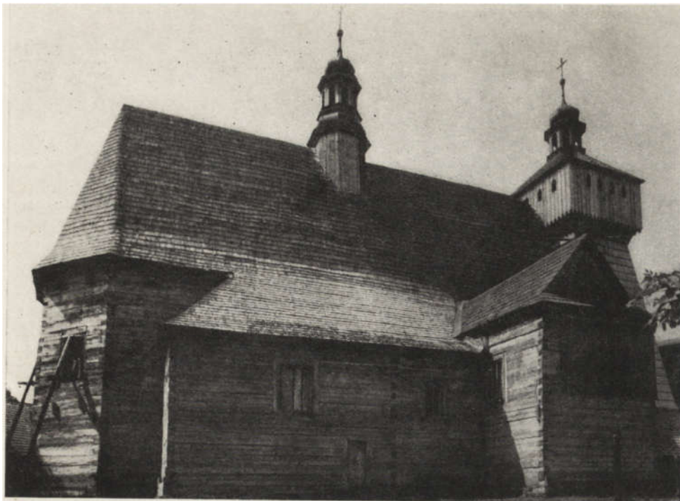
4. Haczów. Dawny kościół par. Widok od pn. — po rozebraniu sobót i zdjęciu oszalowania. Stan z 1962 r. (fot. Jerzy Langda, zbiory IS PAN)
