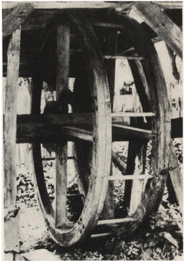
28. Mników, pow. Kraków. Studnia. Koło napędowe wyciągu (fot. A. Saładziak)
