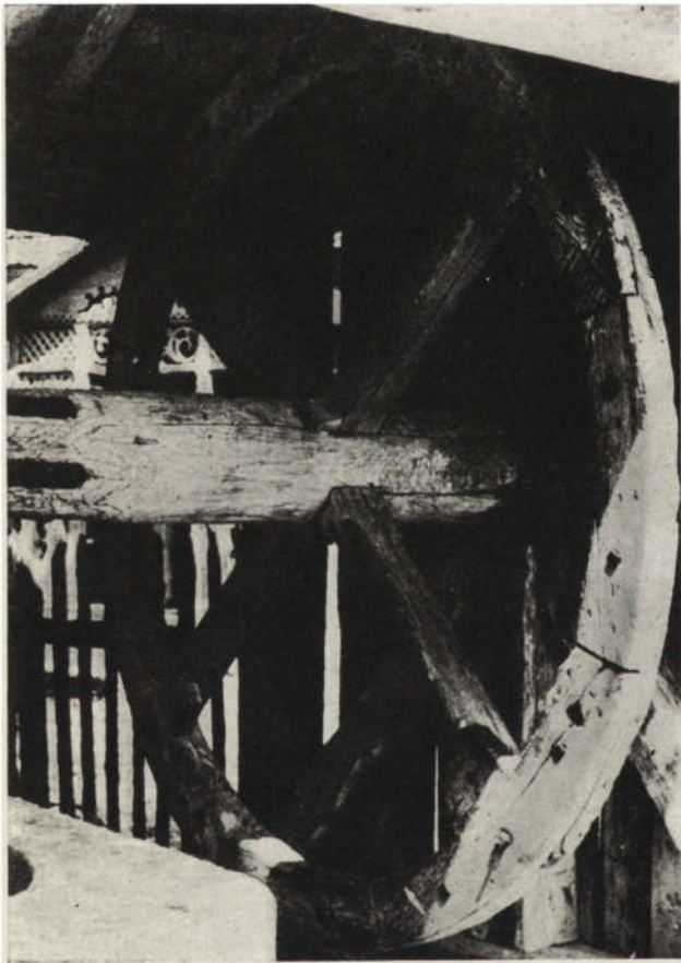
28. Mników, pow. Kraków. Studnia. Koło napędowe wyciągu (fot. A. Saładziak)
