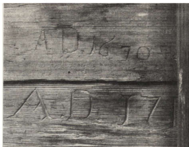
15. Haczów. Dawny kościół par. Daty na pd. zrębie ściany nawy (fot. Jerzy Langda 1965, zbiory IS PAN)
