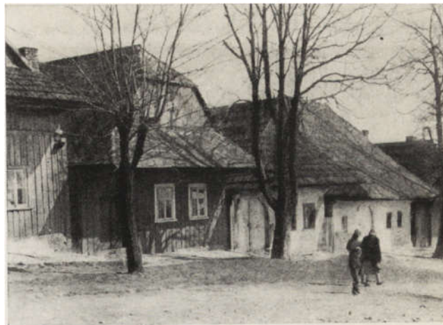
32. Lanckorona, pow. Wadowice. Fragment zabudowy rynku (domy nr nr 79, 81, 83) — stan z 1960 r. (fot. T. Chrzanowski)
