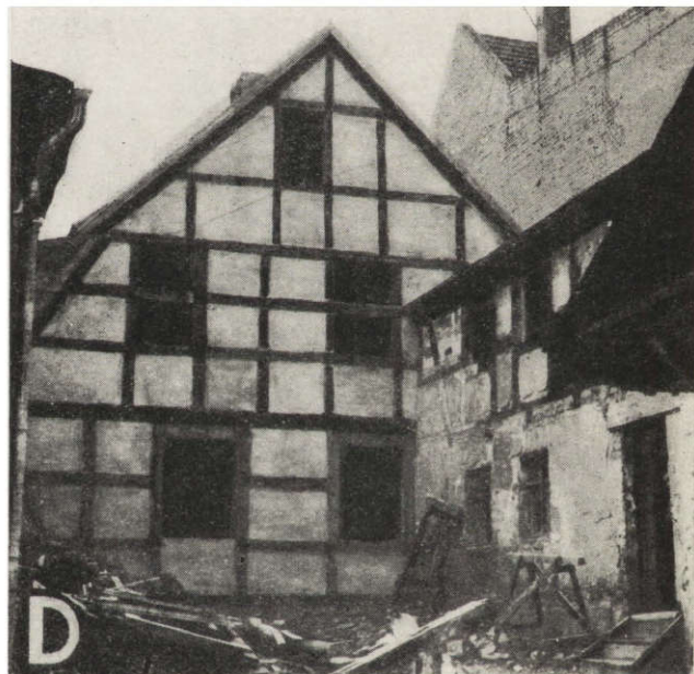
9. Elewacja tylna. Etapy prac konserwatorskich. A — rozbiórka dobudowy ceglanej i uzupełnienie ściany parteru nowym murem, maj—czerwiec 1964 oraz usunięcie wypełnień w partii szczytowej, listopad 1964, B — odsłonięcie śladów pierwotnej konstrukcji parteru, zachowanych w belce oczepowej przyziemia. Podjęcie decyzji o restytucji dawnego wyglądu tej części elewacji, listopad 1964, C — rozbiórka murów ceglanych parteru, wymiana podwaliny, maj 1965, D — stan surowy po częściowej wymianie elementów drewnianych i założeniu wypełnień, czerwiec 1965 (fot. P. Gartkiewicz; B. Kosacki — A)
