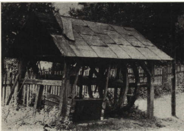
26. Aleksandrowice, pow. Kraków. Studnia. Koło napędowe wyciągu (brak szczebelków na wieńcu koła) — stan z 1965 r. (fot. A. Saładziak)
