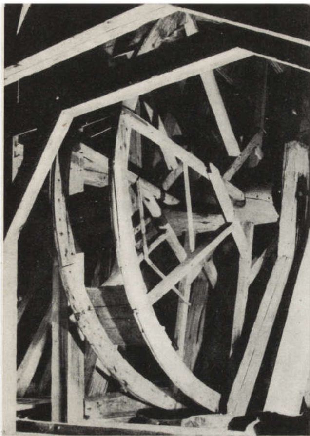
5. Pelplin. Katedra, dreptak — stan z 1963 r. (fot. A. Saładziak)
