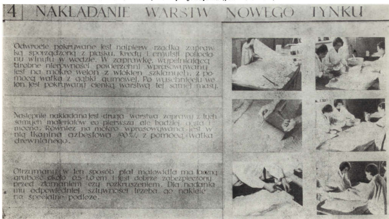
1. Plansza „Nakładanie warstw nowego tynku”. Fotografie dokładnie ilustrują tekst. Podział napisów na odcinki ułatwia porównywanie z fotografiami i proces przyswajania (fot. W. Górski)
