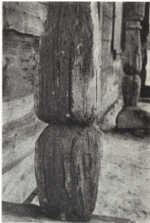
3. Niewłaściwie dobrana masa uzupełniająca pęka i odstaje od drewna (fot. Z. Sroczyński)
