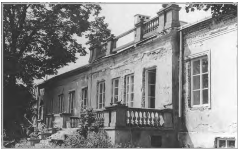
Żółwiński dwór w czasie remontu (ok. 1972 r.)
