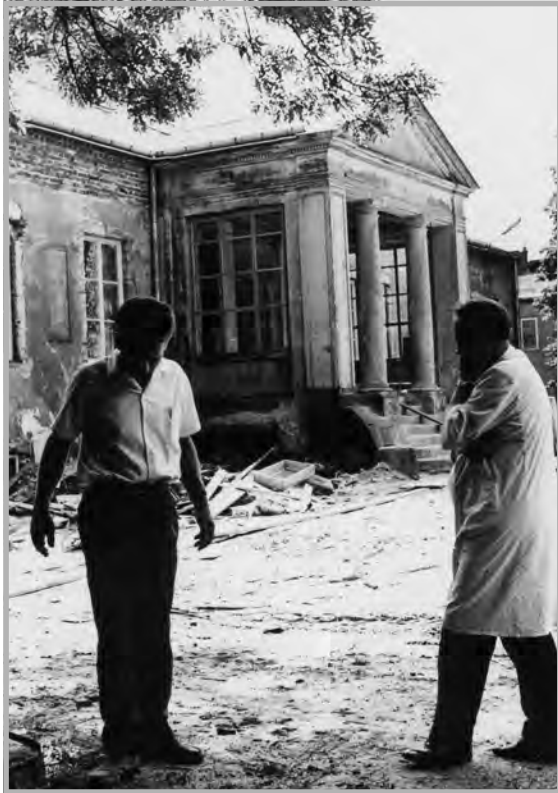
Dwór w trakcie remontu (początek lat 70. XX w.) Na pierwszym planie od lewej: Józef Choynowski i Jerzy Kremky
