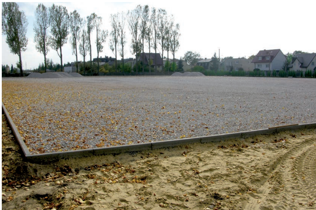
Układanie warstwy drenażowej boiska
