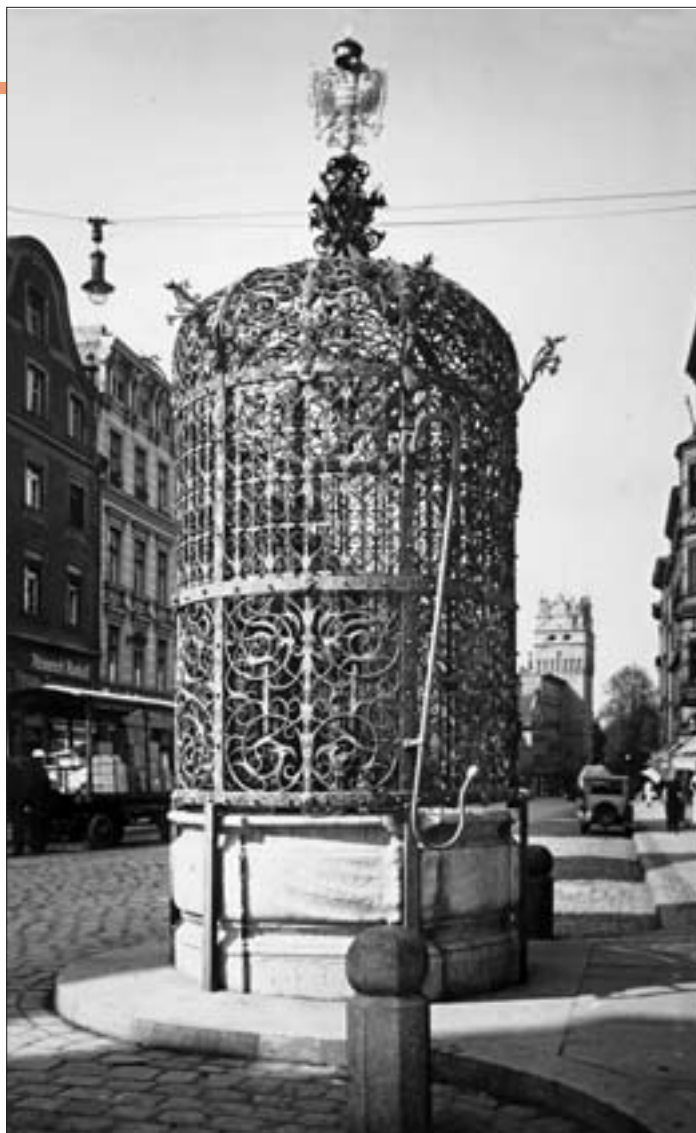
5. Piękna Studnia po konserwacji w 1935 r. Fot. Soboczyk, 1937 r. 5. Beautiful Well after conservation in 1935. Photo: Soboczyk, 1937.
