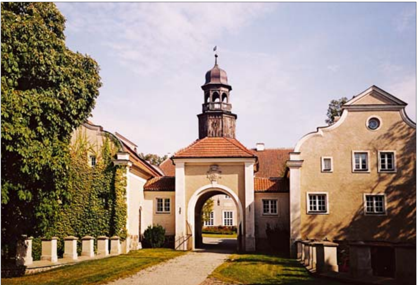
1. Galiny. Brama wjazdowa do kompleksu pałacowego. Fot. M. Zwierowicz. 1. Galiny. Entrance gate to the palace complex. Photo: M. Zwierowicz.
