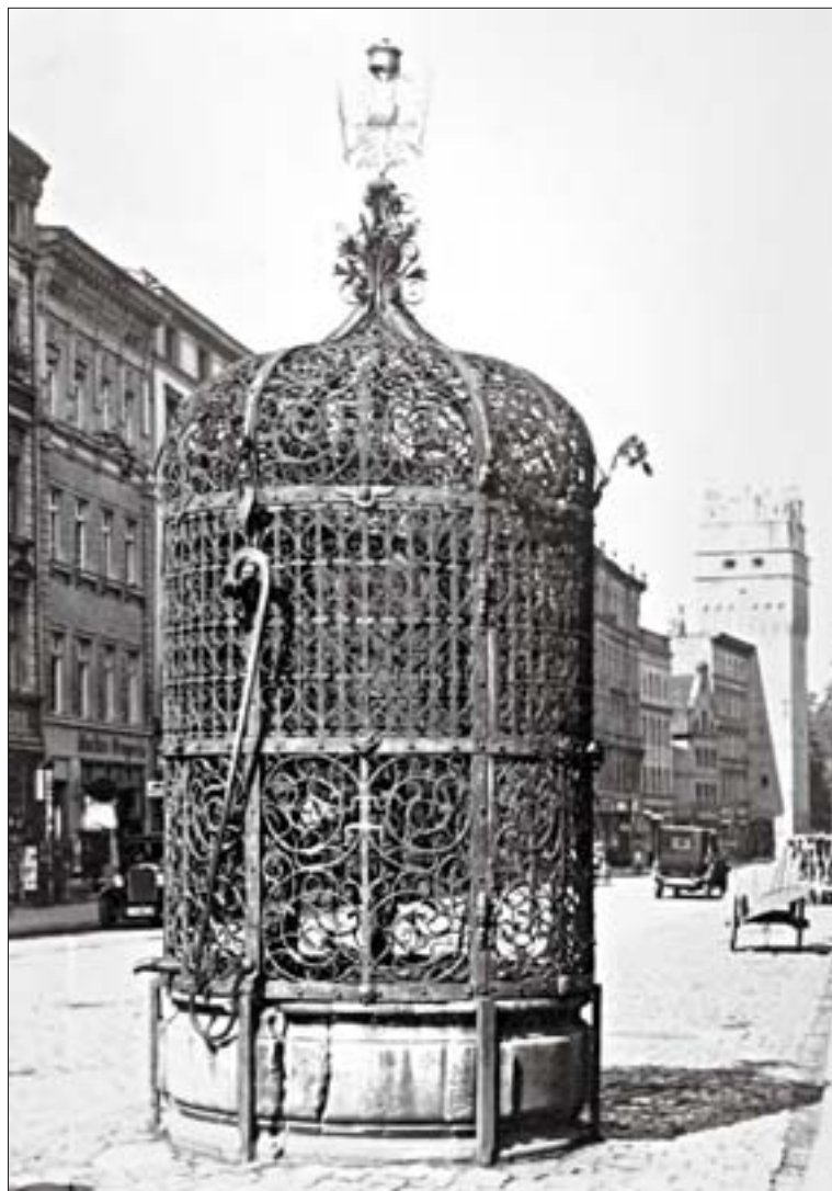
3. Piękna Studnia przed konserwacją. Fot. F. Rassmann, 1934 r. 3. Beautiful Well prior to conservation. Photo: F. Rassmann, 1934.
