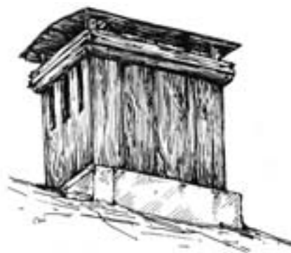
6. Wilków nad Wisłą, gm. Leoncin, nr posesji 20, drewniane zwieńczenie wywietrznika z obory.
