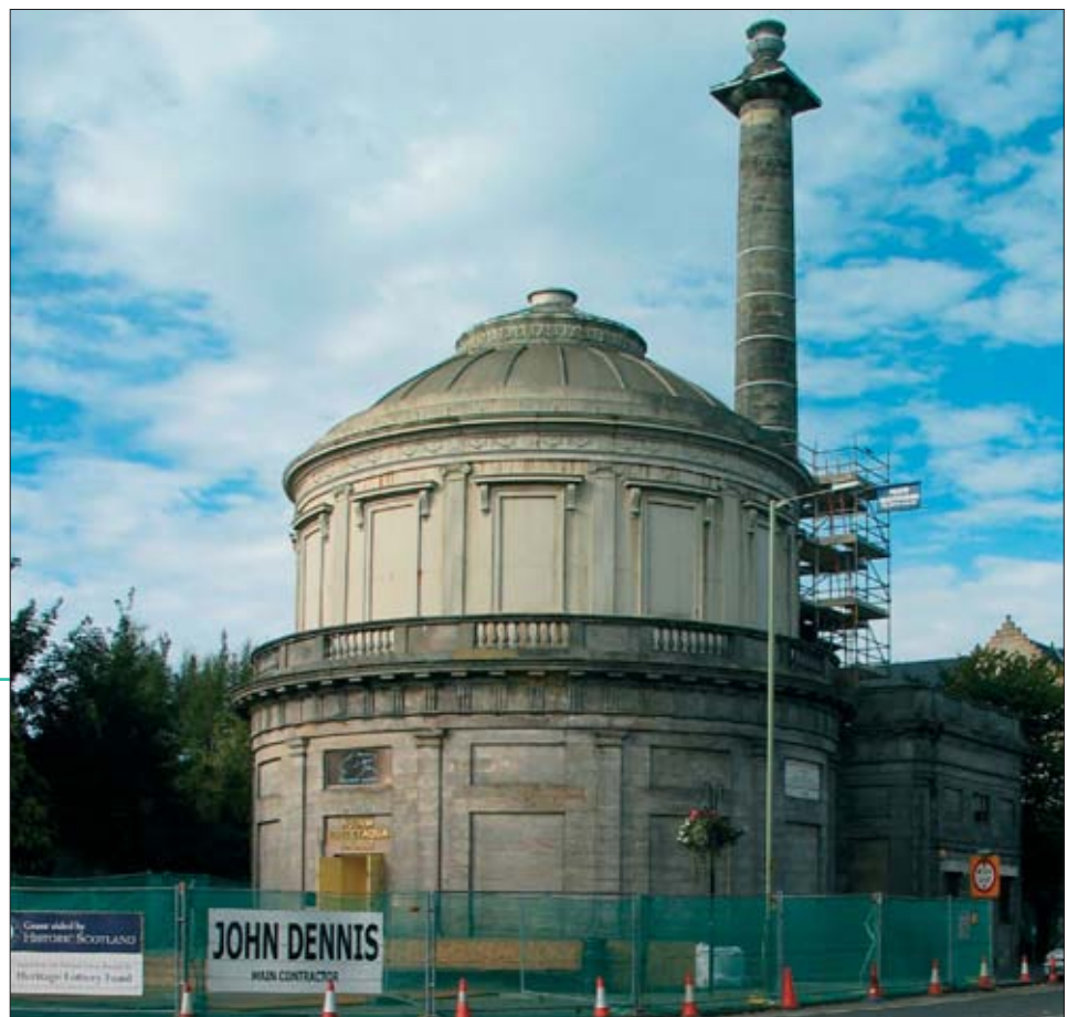
4. Wodociąg w Perth podczas prac konserwatorskich (ze zbiorów Historic Scotland).
