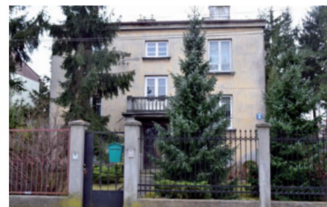
Dom przy ul. Barbórki, dawniej Halickiej, w którym urządzono skrytkę do przechowywania Żydów
