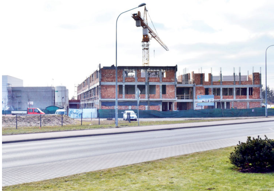
Największa inwestycja ostatnich lat – budowa zespołu szkolno-przedszkolnego w Nadwiśle
