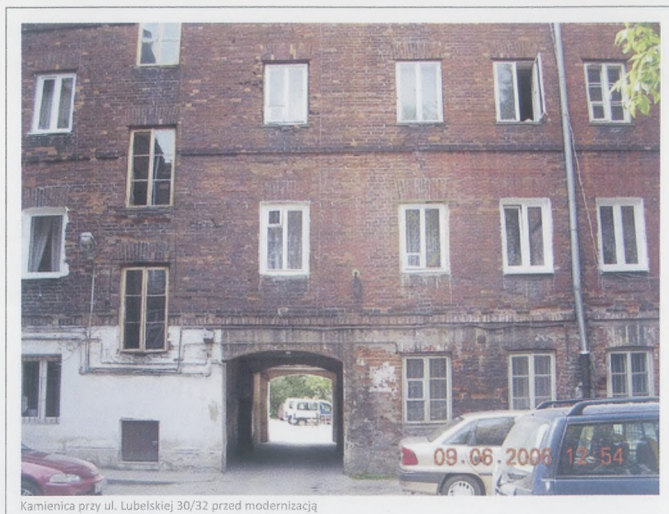
Kamienica przy ul. Lubelskiej 30/32 przed modernizacją
