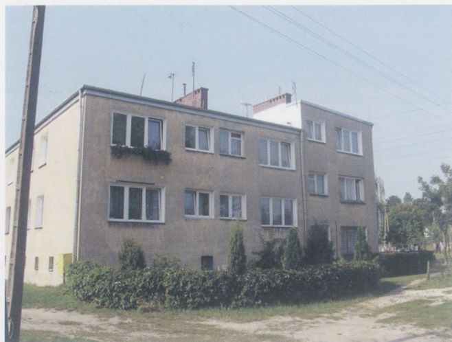
Osiedle przy ul. Warszawskiej 3
