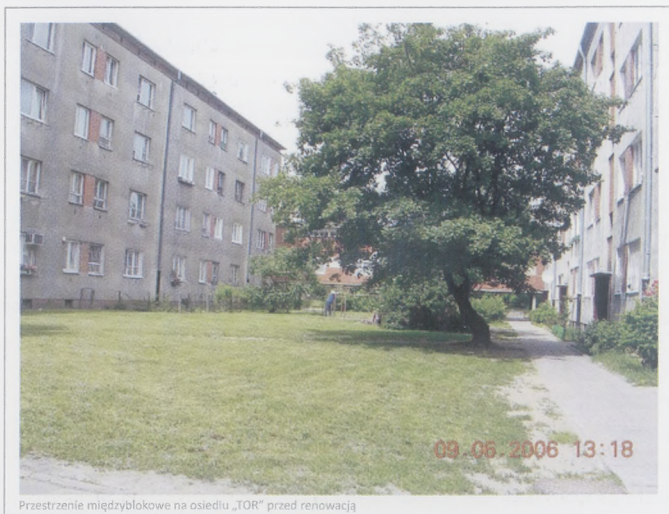
Przestrzeń międzyblokowa na osiedlu „TOR” przed renowacją
