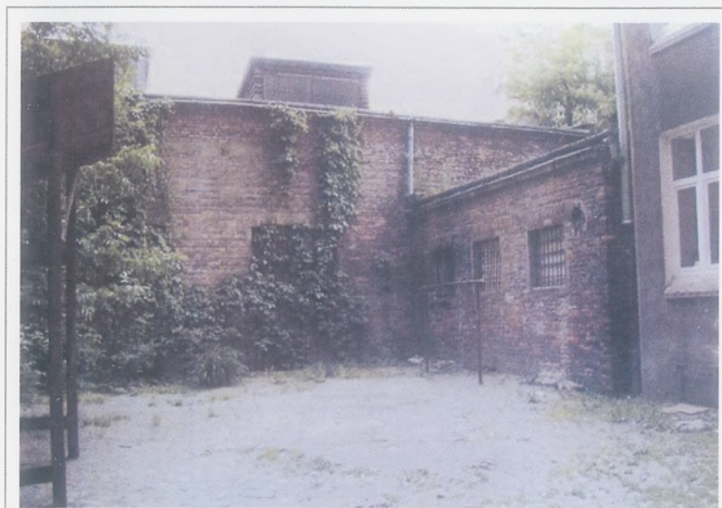
Drugie podwórze kamienicy przy ul. Tarczyńskiej 11: stan obecny
