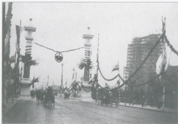
7. Ulica Aleksandrowska w dniu przyjazdu pary cesarskiej – wieże kościoła św. Floriana w budowie, fot. Konrad Brandel, 1897 r.
