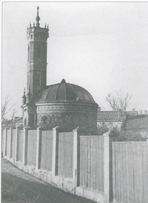
38. Wodociąg Grotowski – widok od ul. Brukowej, fot. Henryk Poddębski, 1937 r.
