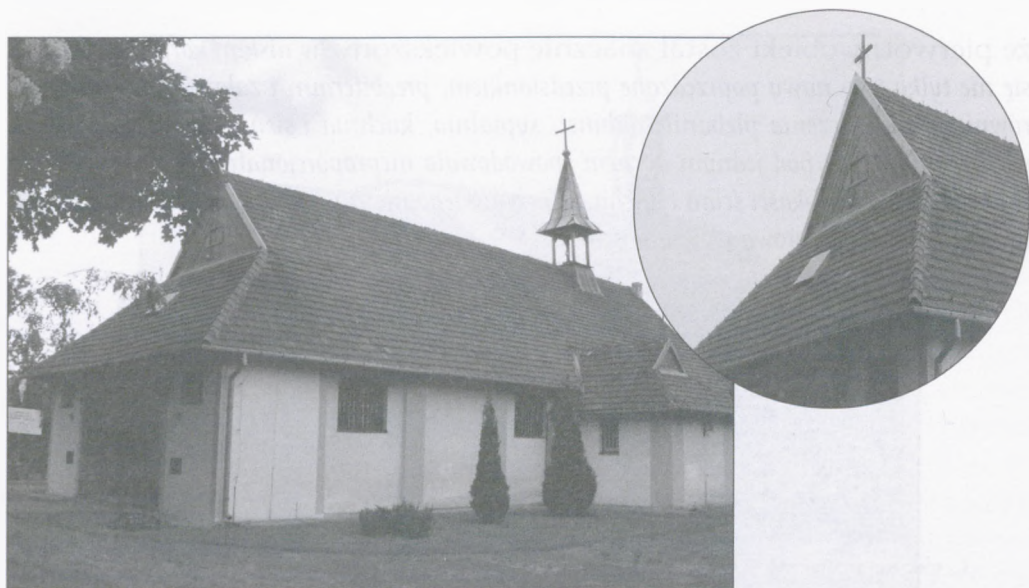
il. 12, 13. Kościół pw. Zmartwychwstania Pańskiego na Targówku Przemysłowym. Dach naczółkowy od strony wejścia głównego. Fot. J. Wiśniewski.
