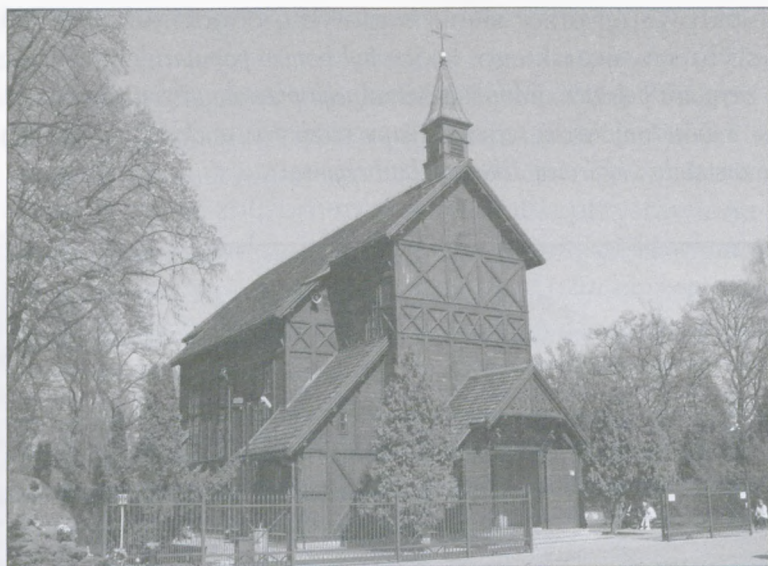
il. 6. Kościół cmentarny pw. św. Wincentego à Paulo na Bródnie – widok od frontu. Fot. J. Wiśniewski.
