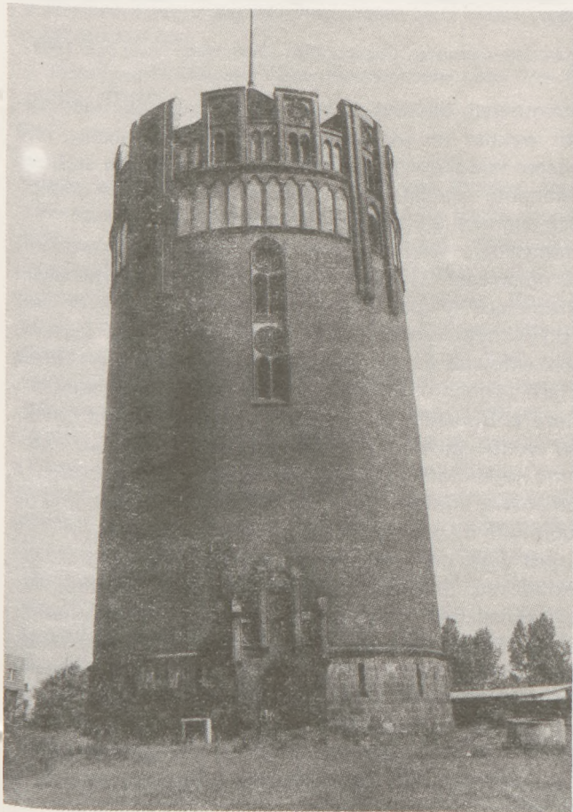
1. Gliwice, ul. Poniatowskiego. Wodociągowa wieża ciśnień z 1894 r.
