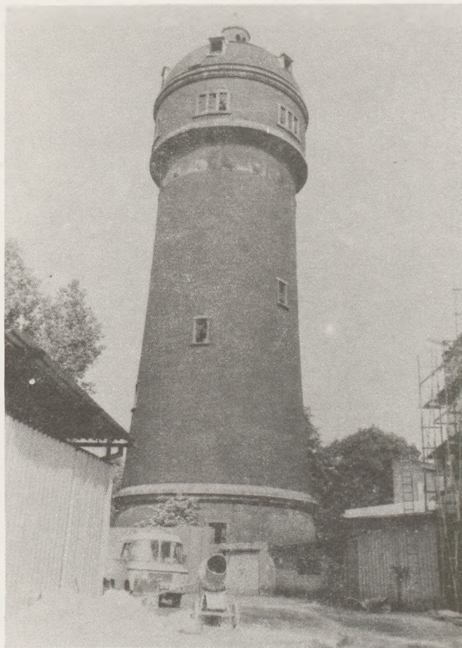
7. Świętochłowice, ul. Armii Czerwonej 62. Wodociągowa wieża ciśnieni z 1905 r.
