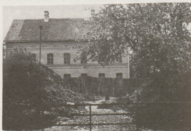
10. Wjazd na teren budowy Domu „Gazety Olsztyńskiej” przecinający linię murów obronnych
