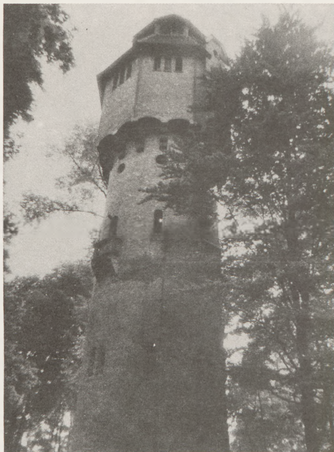
3. Katowice-Giszowiec, ul. Górniczego Stanu. Osiedlowa wieża wodna z 1909 r.
