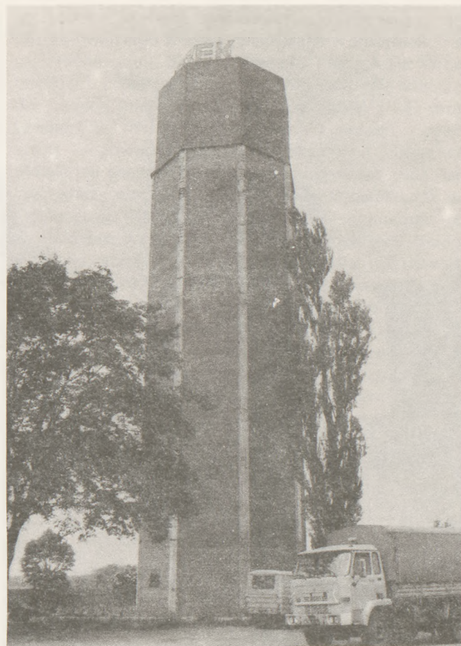
13. Toszek, ul. Gliwicka. Wodociągowa wieża ciśnieni z lat trzydziestych XX w.
