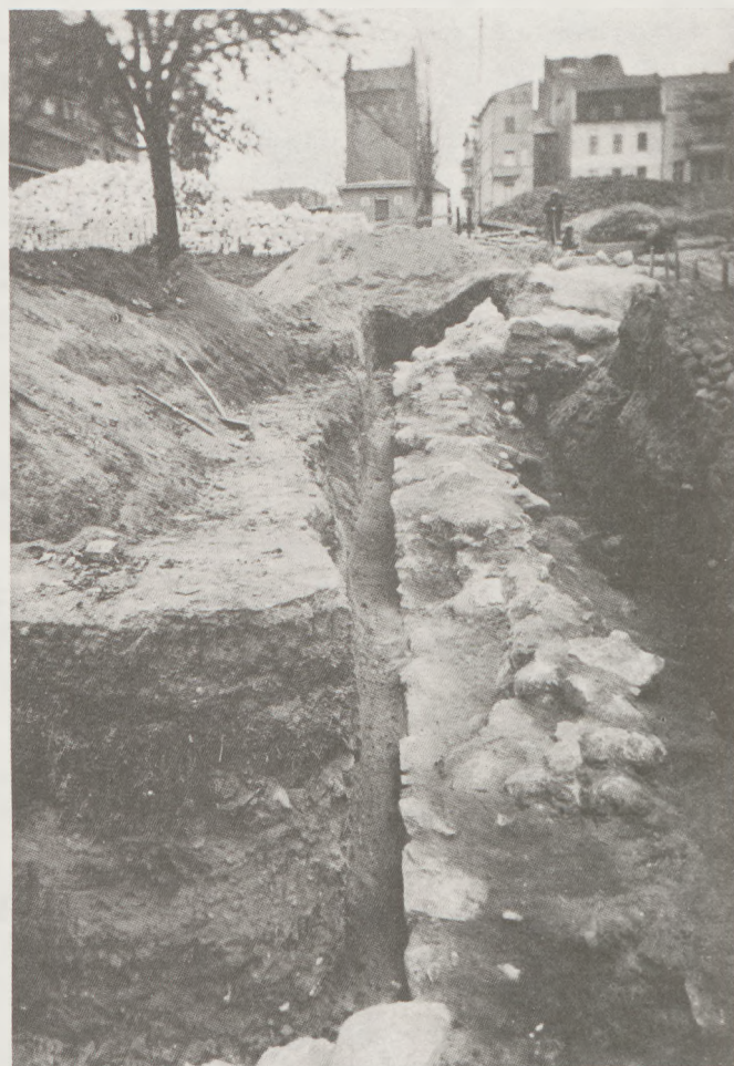
5. Fragment muru obronnego przy Wysokiej Bramie odsłonięty w czasie prac prowadzonych w latach sześćdziesiątych (fot. Krauth)
