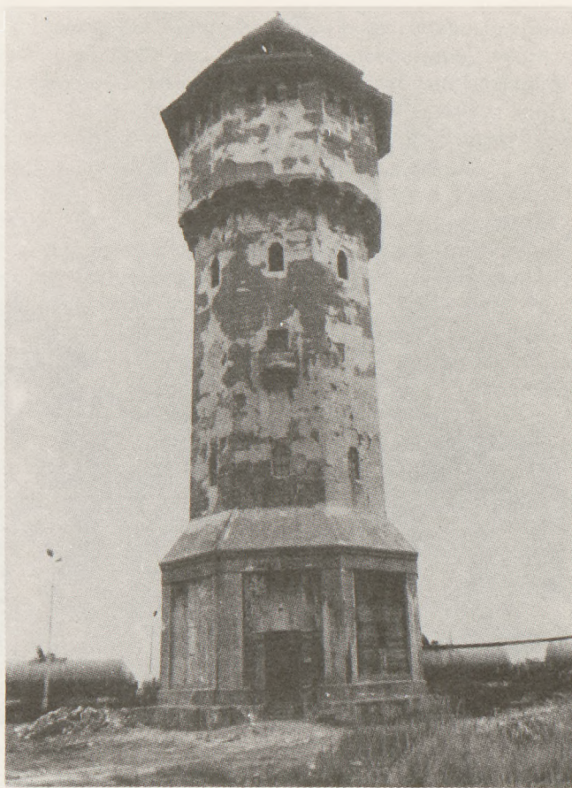
5. Katowice-Szopienice, I Kompleks Huty Metali Nieżelaznych „Szopienice”. Przemysłowa wieża wodna z 1913 r.
