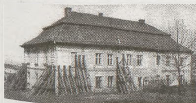
17. Wieliczka — Pałac Salinarny z XVIII w., elewacja wsch. przed remontem. Fot. z archiwum PSOZ Kraków
