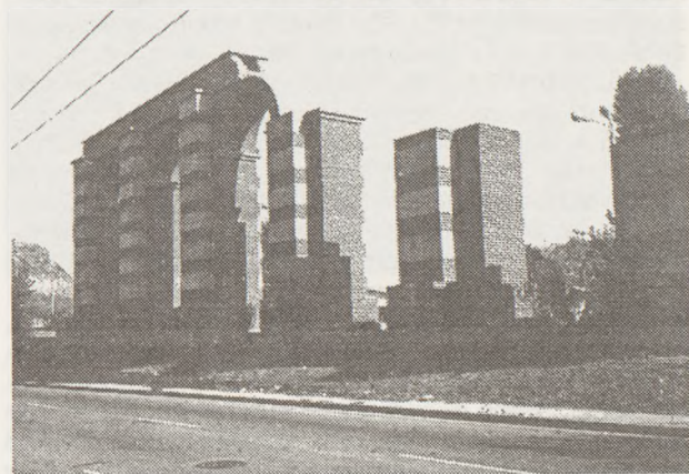
1. Płowdiw, autostrada komatiewska. Zrekonstruowany odcinek południowy akweduktu (wszystkie fot. M. Biernacka-Lubańska)
