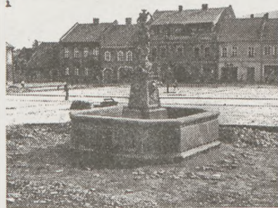
12. Myslenice — Rynek w trakcie remontu nawierzchni. Fot. J. Krzyszkowski
