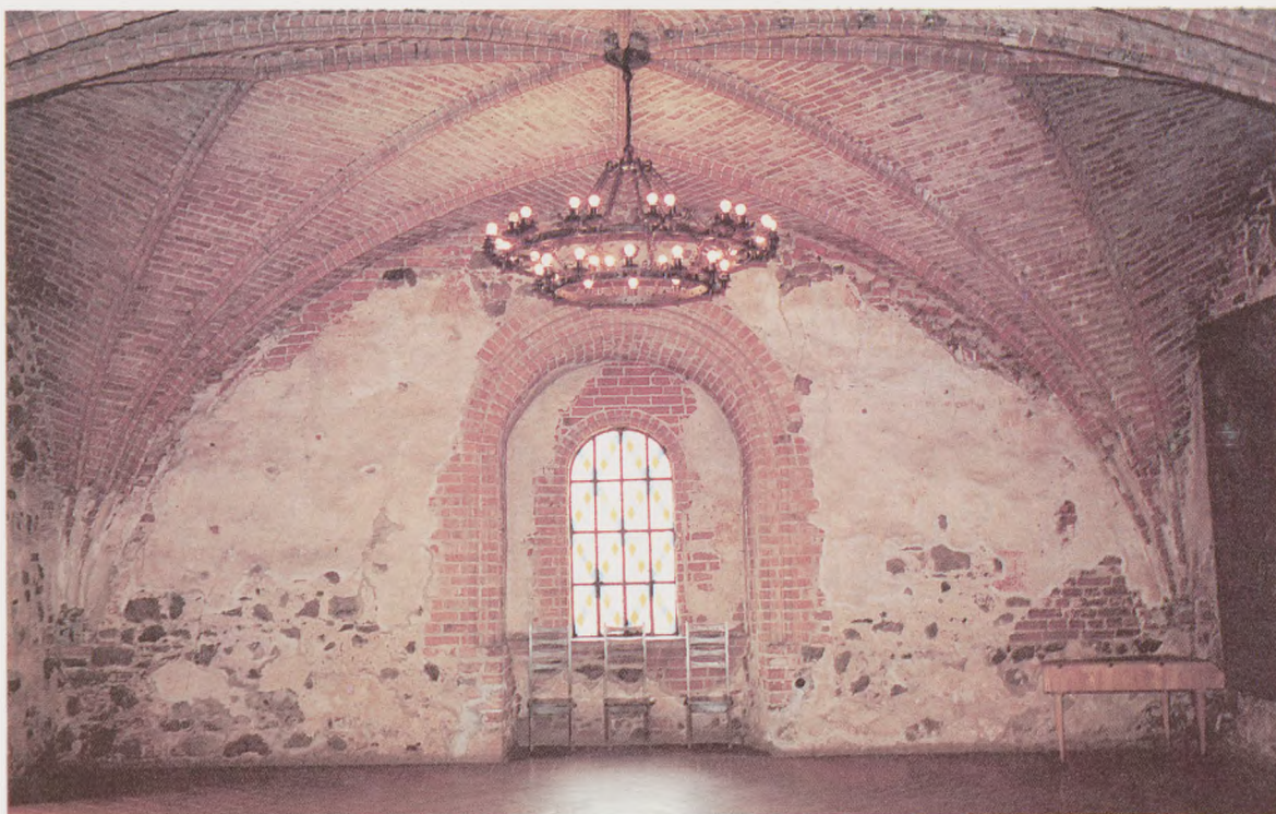
A. Troki, zamek na wyspie po odbudowie, sala w południowym skrzydle, ściana południowo-zachodnia z fragmentami oryginalnych tynków pod malowidła, 1410-1470 (?), stan obecny. Fot. A. Szymańska
