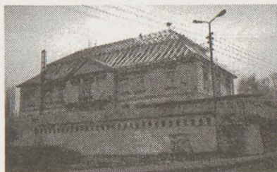
18. Wieliczka — Pałac Salinarny z XVIII w. w trakcie prac remontowych. Fot. z archiwum PSOZ Kraków
