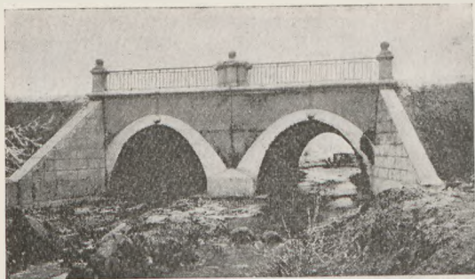
Rys. 49. Most na st. Łazy, po odbudowie.
