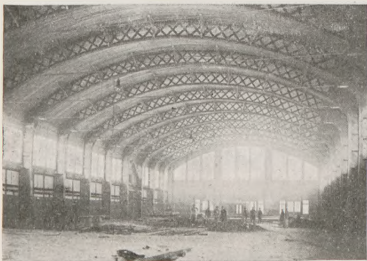
Rys. 75. Dworzec tymczasowy Warszawa Gł. podczas budowy.
