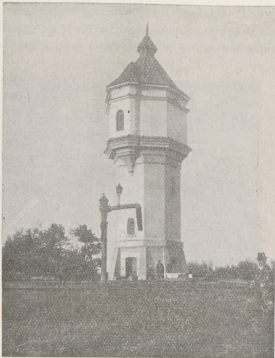
Rys. 76. Ruda Tałubska, wieża ciśnię.
