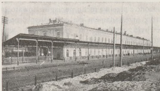
Rys. 57. Dworzec Warszawa Wschodnia po odbudowie.
