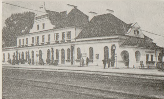
Rys. 60. Dworzec w Białej Podlaskiej, po odbudowie.
