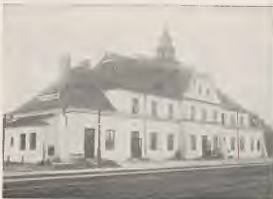
Rys. 65. Dworzec w Żyrardowie, po odbudowie.
