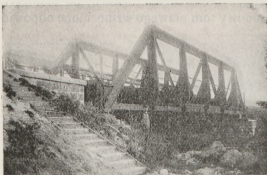
Rys. 40. Most na Wildze, po odbudowie.
