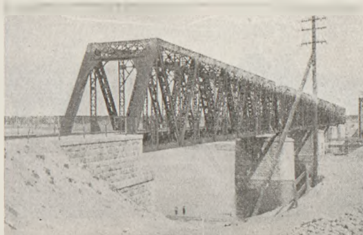
Rys. 26. Most na Bugu, pod Małkinią. Nowy most pod lewy tor.
