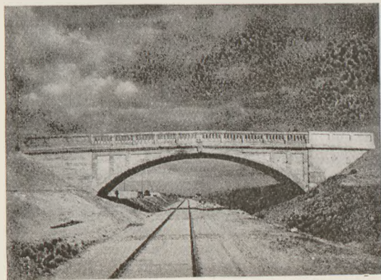
Rys. 42. Wiadukt nad torami linii Kutno-Strzałkowo.
