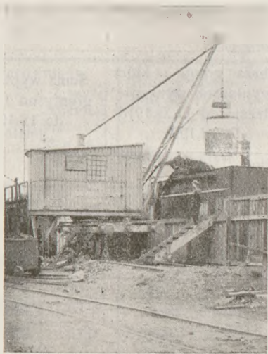
Rys. 185. Dźwig elektryczny na st. Piotrków.
