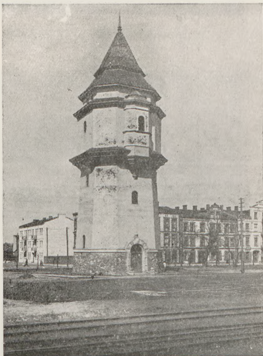
Rys. 79. Żyrardów, wieża ciśnień po odbudowie.
