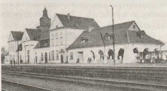
Rys. 54. Dworzec w Grodzisku, po odbudowie.
