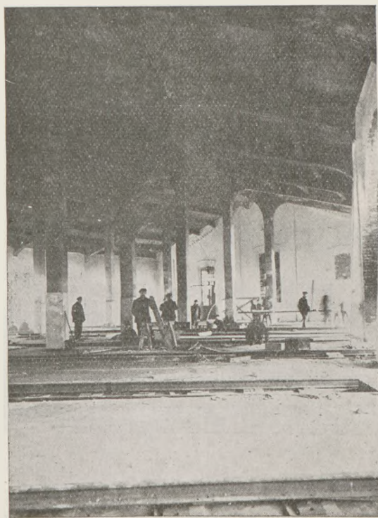
Rys. 91. Wnętrze żelazobetonowej parowozowni w Łazach.
