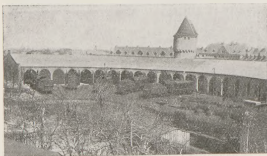
Rys. 90. Piotrków Tow. Nowa parowozownia.
