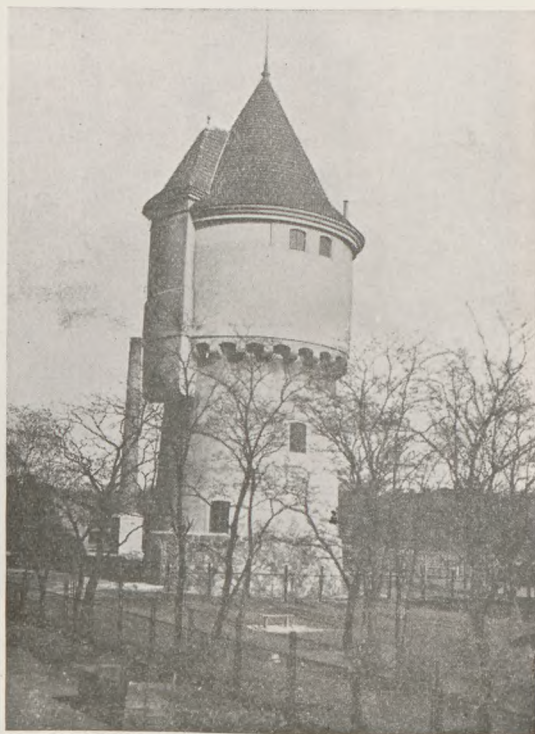
Rys. 77. Skierniewice, wieża ciśnię.
