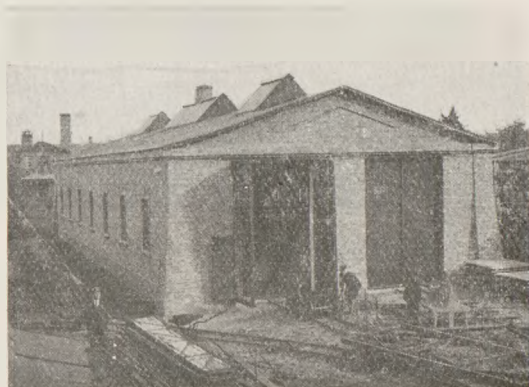
Rys. 207. Naprawnia wagonów w Krośniewicach.
