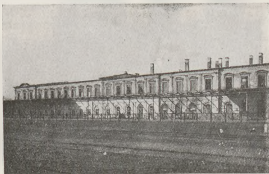
Rys. 56 Dworzec Warszawa-Wsch., przed odbudową.
