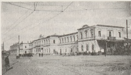
Rys. 55. Dworzec Warszawa-Wsch., przed odbudową.
