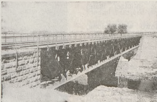
Rys. 36. Most na Nerze, pod Łodzią, po odbudowie.
