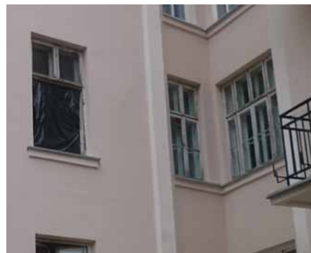
Widok okna w lokalu ZGN po remoncie elewacji, zanim zdecydowano się na jego wymianę.
