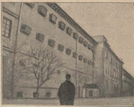
Gmach główny więzienia przy ulicy Pawiej. Szara, posępna budowla, okna tajemniczo zakryte. Smutek i nuda zdają się wydławić z tych murów.
