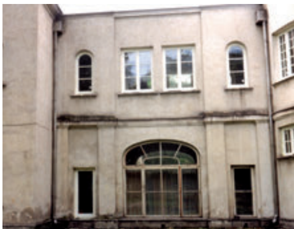
Biblioteka przed remontem
