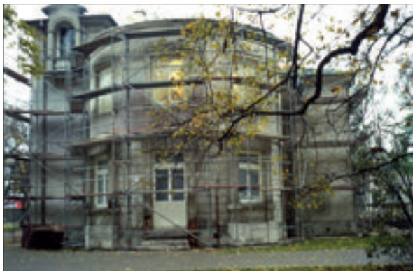
Biblioteka podczas remontu
