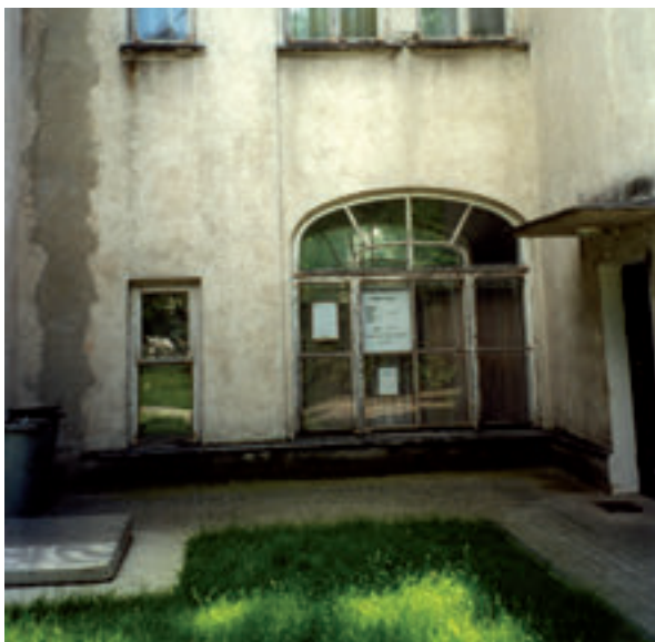
Biblioteka przed remontem
