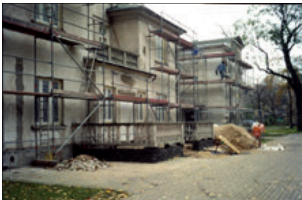
Biblioteka podczas remontu
