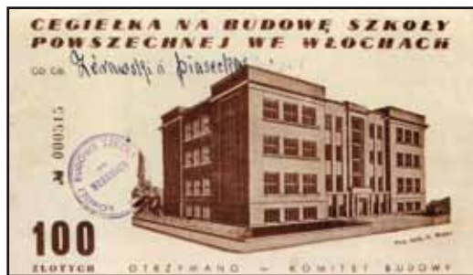
Cegielka na budowę szkoły przy ul. Promienistej (Szkołna Izba Pamięci)
