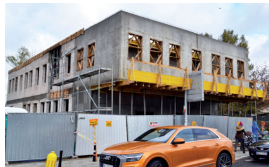
Nie minął miesiąc, a mury pociągnięto do pierwszego piętra FOT. AM
