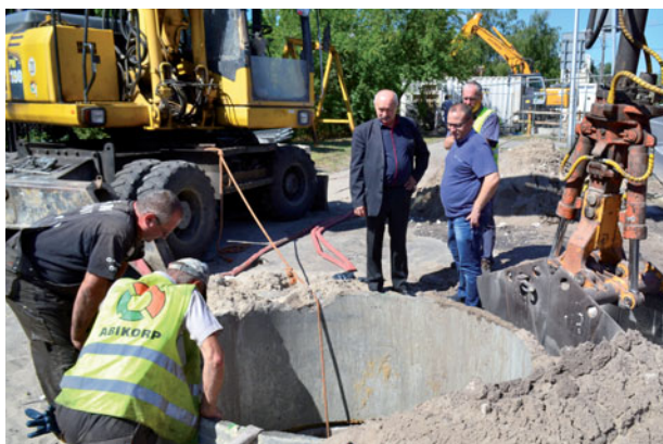
Budowę kanalizacji wzdłuż ul. Lucerny wizytowali burmistrz Łukasz Jeziorski i jego zastępca, Zdzisław Gójski
