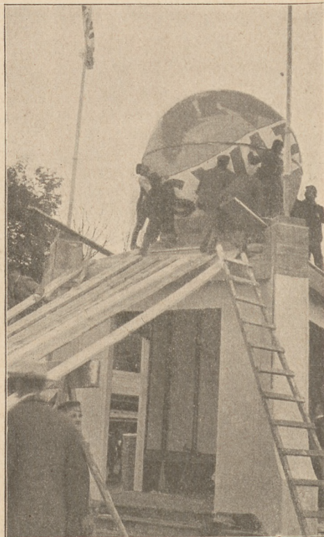
Równocześnie kończy się energicznie budowa pawilonu „Świata”.
