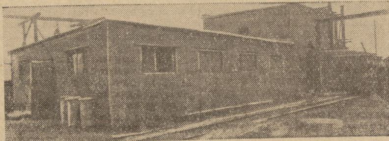
Pierwsze prefabrykaty z elektrowni Chorzów znajdują takie oto zastosowanie.
