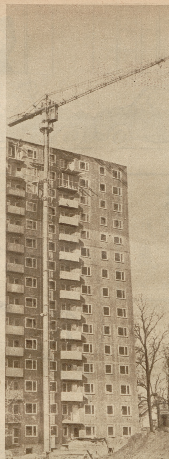
Mechanizacja w budownictwie zatacza coraz szersze kręgi. W Monachium zastosowano ostatnio najnowszy typ dźwigu „rosnącego” w pięciometrowych odcinkach równocześnie z domem. CAF
