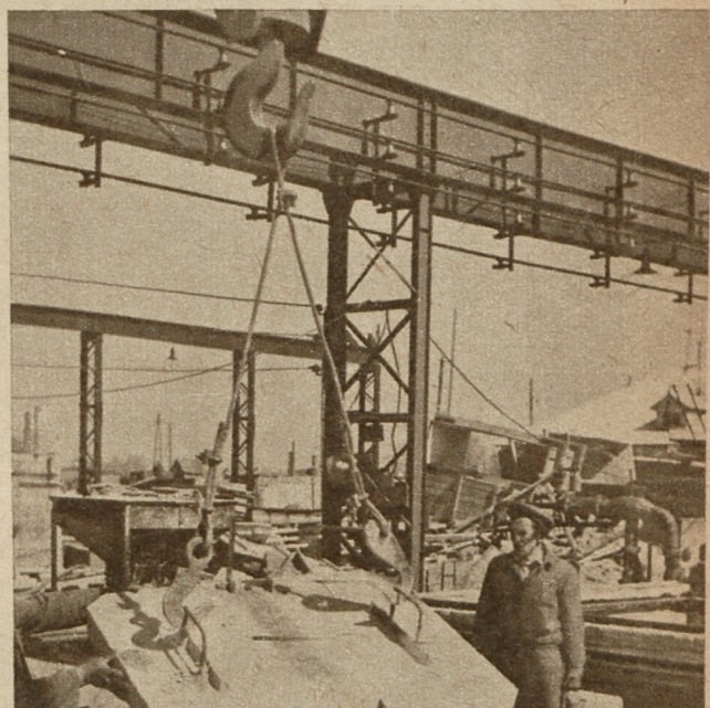
Zakłady budowy elementów budowlanych w Jelonkach uruchomiły ostatnio jeszcze jeden dział produkcji prefabrykatów. Przy współudziale Jelonków buduje się m. in. osiedle na Wierzbnie. CAF
