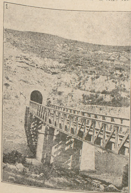
Wyjazd z wielkiego tunelu pod Czołokova Mahala.
